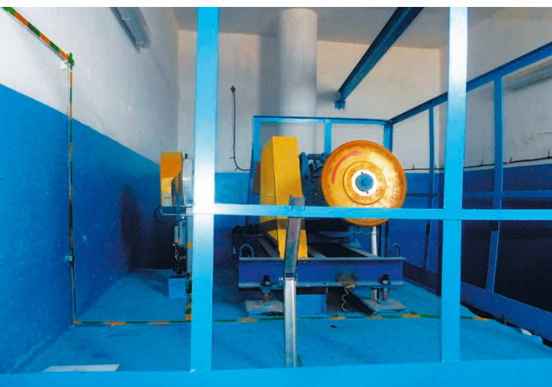
Лифт, который находится на стадии пусконаладочных работ
